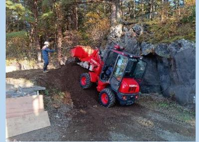
河口湖訓練場において、富士吉田消防署と河口湖消防署の職員が合同で、土砂災害対応訓練を実施しました。コンパネと単管を用いた応急土留めの方法や重機を活用した掘削方法を確認しました。
